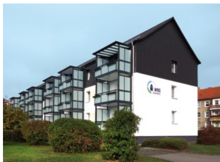
Sanierung in der Harzstraße/Rottleberode
