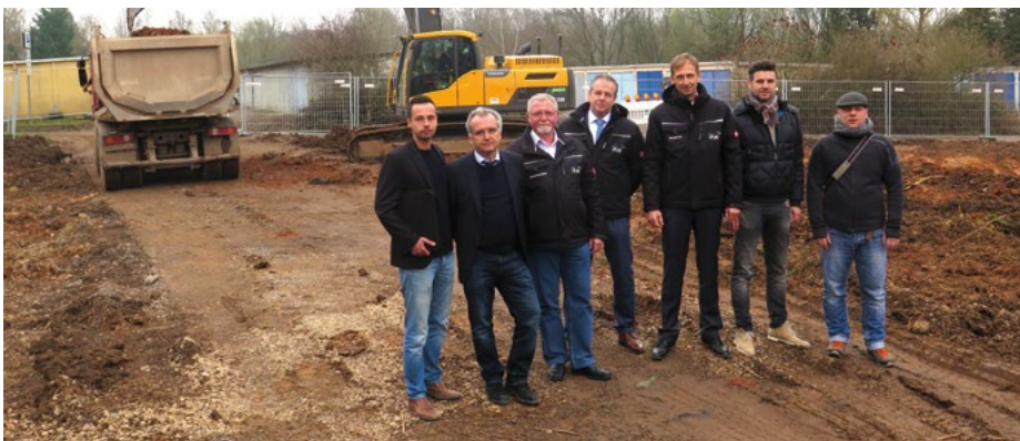
Neubau Borntal: Baufeldübergabe durch den Vorstand unserer WBG an Firma HABAU
