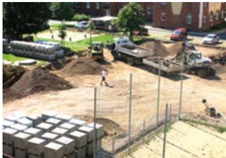
Start der aktuellen Pflasterarbeiten
