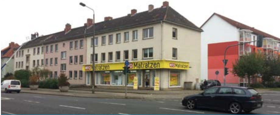
WBG-Objekt in der Halleschen Straße 77–81 vor der Sanierung
