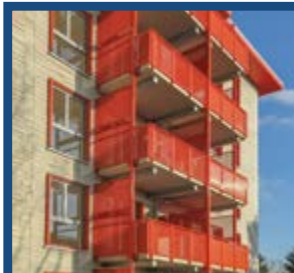
Neubau am Borntal, Balkone
