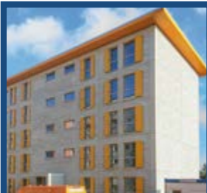
Neubau am Borntal, Nordhausen
