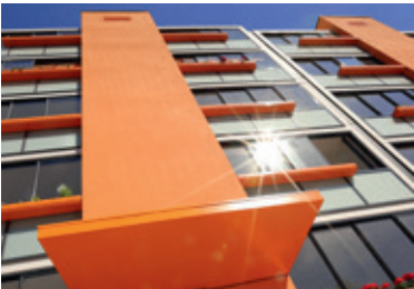
Stolberger Straße 91-105 & 107-113 Sanierung 2019/2021
