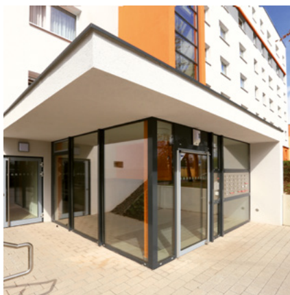
Neuer Glasanbau Eingang Am Aueblick, Nordhausen
