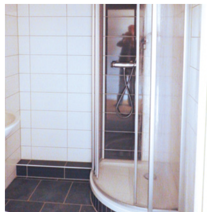
Wohnungssanierung nach neuer Strategie
