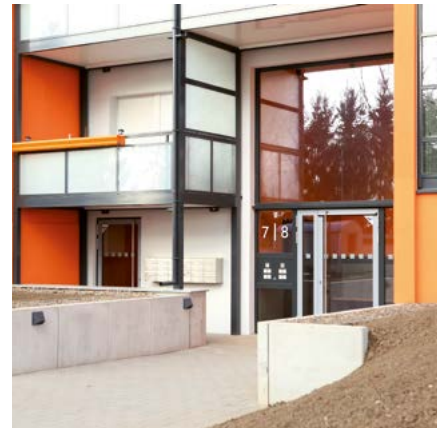
Neuer Eingangsbereich Aueblick 5-8
