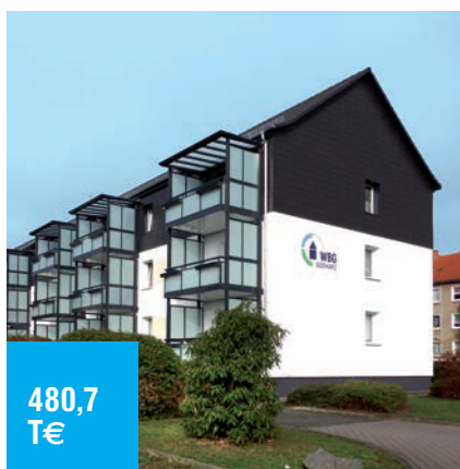
Komplexsanierung mit Balkonanbau, Rottleberode
