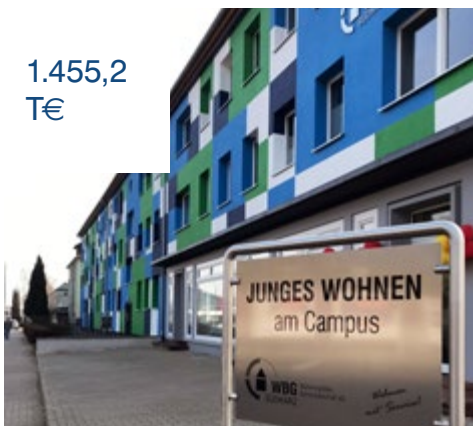
Komplexsanierung, Hallesche Straße 77–81, Nordhausen
