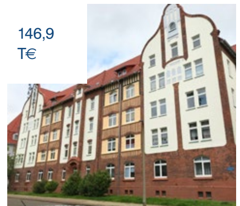
Dach- und Fassadensanierung, Hardenbergstraße 3–7, Nordhausen
