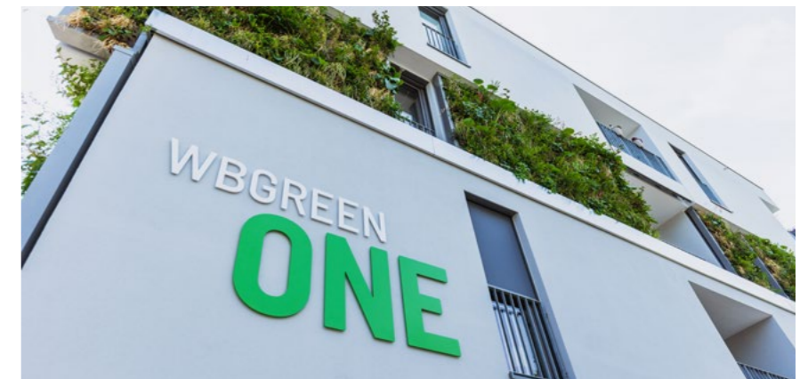
Neubauprojekt in der Stolberger Straße 18
