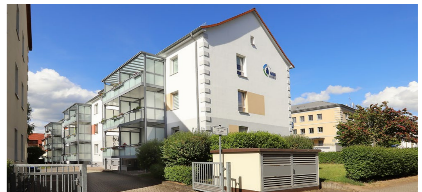
Balkonanbau auf dem Taschenberg
