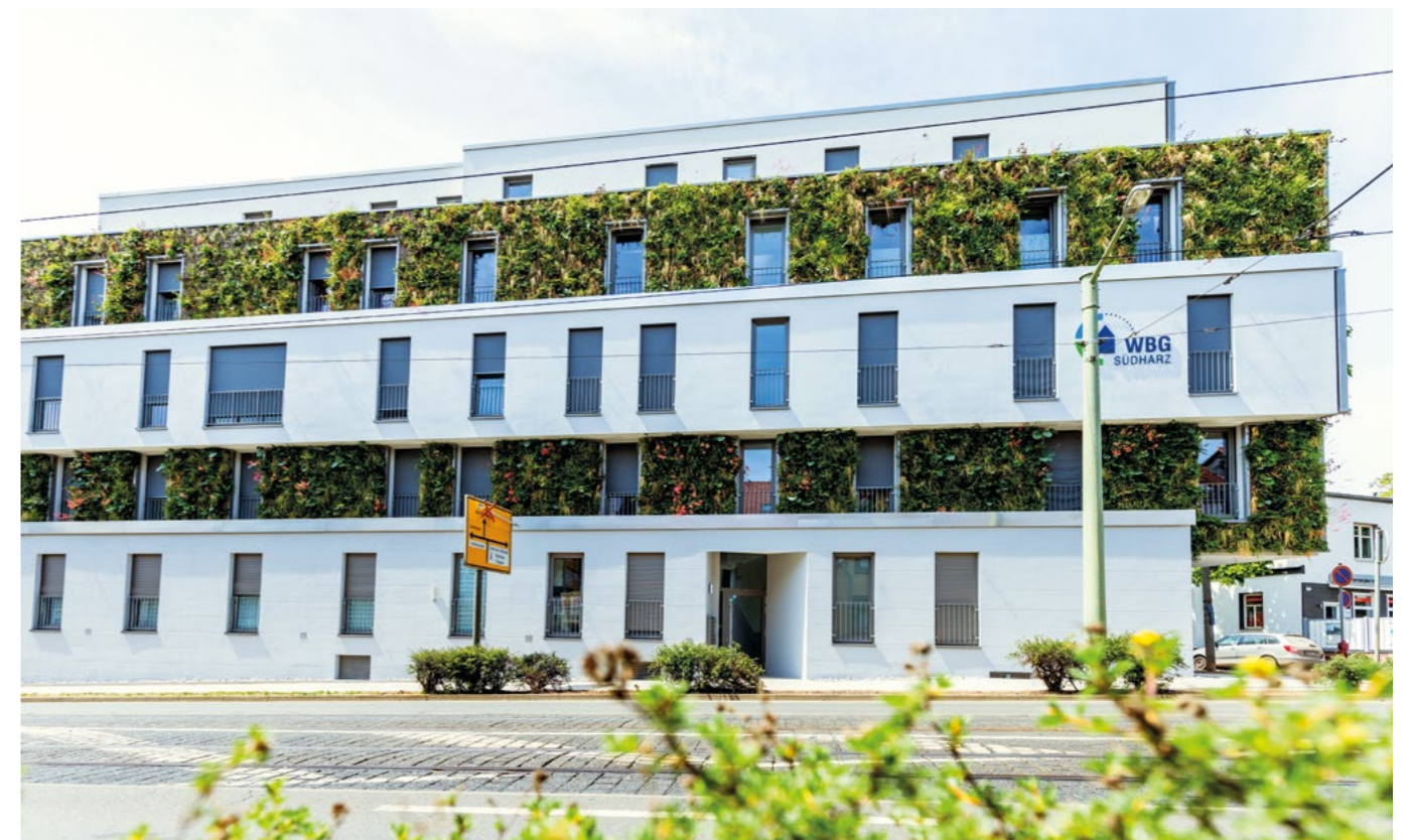
Neubauprojekt in der Stolberger Straße 18
