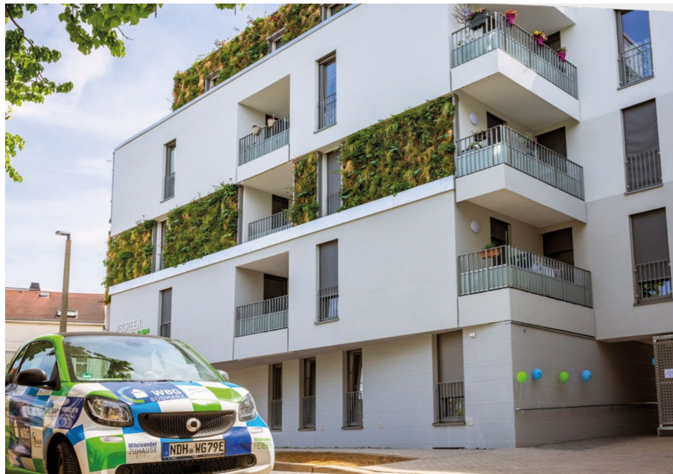
Neubauprojekt in der Stolberger Straße 18
