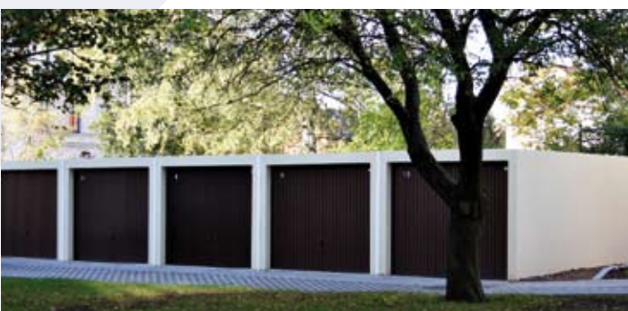
Neuerrichtung von 10 Fertiggaragen in Nordhausen
